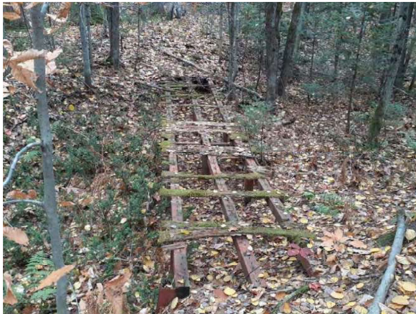
Figure 20 : Ancien pont pour accéder à la zone près de la rivière
